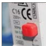
przycisk kontrolny TEST
