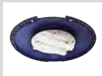
Montaggio del corpo illuminante.
