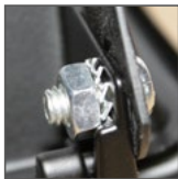
mocowanie uchwyty z oprawą (podkładki zębate)
