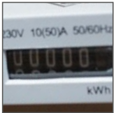
mechaniczny licznik 1-fazowy
