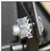
mocowanie uchwyty z oprawą (podkładki zębate)
