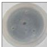
otwór do poprowadzenia przewodów zasilających
