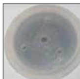
otwór do poprowadzenia przewodów zasilających
