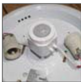
rozmieszczenie gniazd w plafonierze
